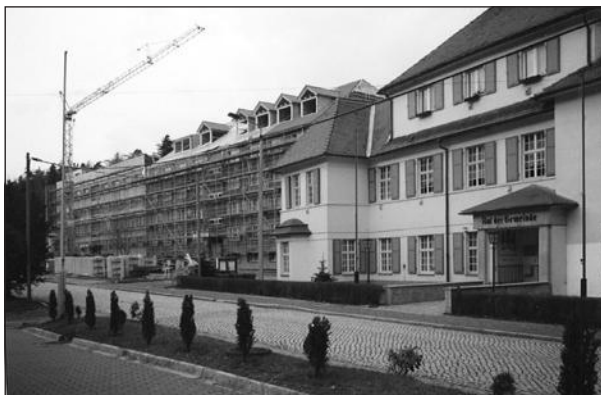
Bettenhaus der GES, Sanierung 1993
